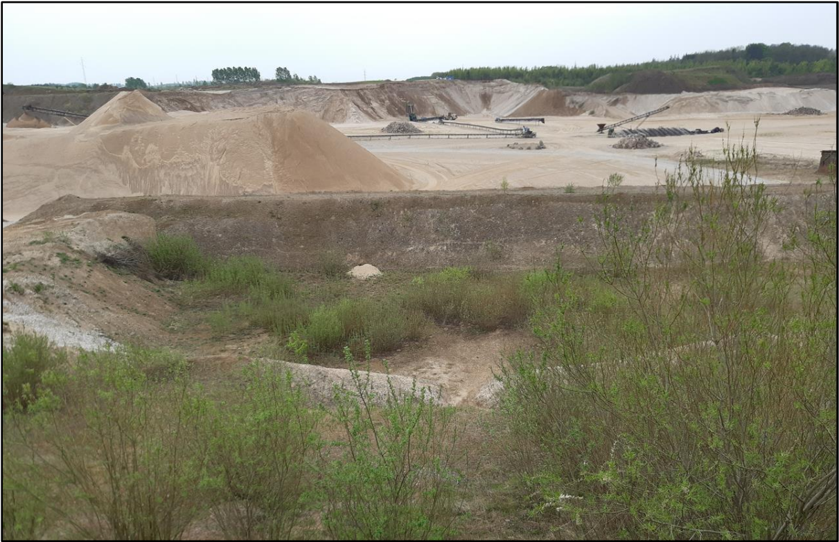
Figur 2-7 Det tørlagte bassin set fra nord
