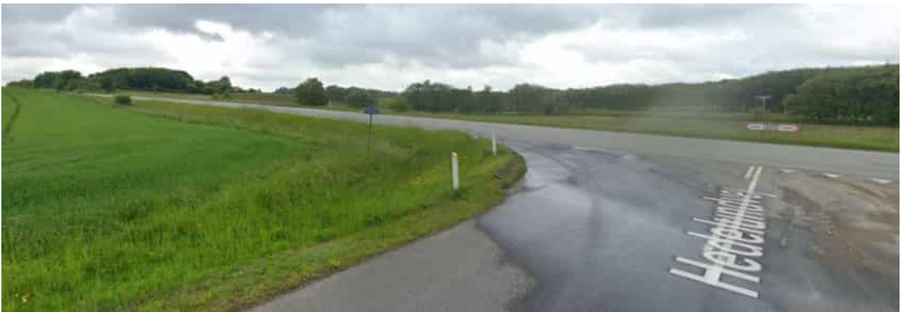
Figur 9-12: Oversigt fra Hedelundvej mod Vejlevej mod nord. Kilde: Google Maps, 2022.
