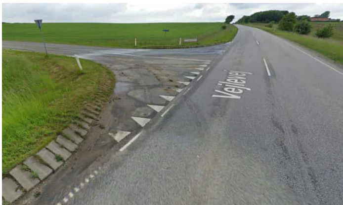
Figur 9-15: Udformning af krydset Vejlevej/Hedelundvej. Billedet er taget på Vejlevej syd for krydset. Kilde: Google Maps, 2022.
